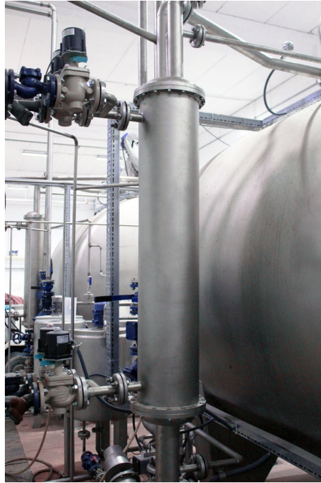
Makine yanındaki Isıtma-Soğutma-Eşanjörü
